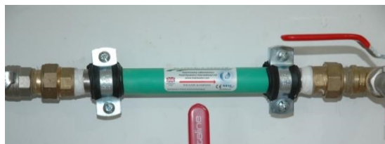
Prawidłowy sposób montażu urządzenia
