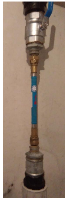
Prawidłowy sposób montażu urządzenia
