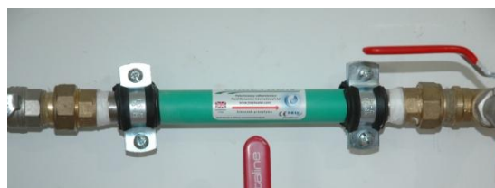
Prawidłowy sposób montażu urządzenia
